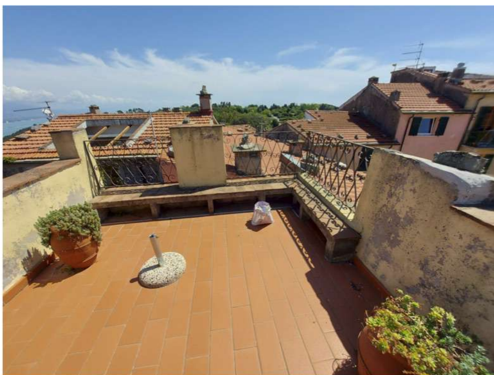
Foto n°2 - Vista del terrazzo/lastrico solare lato Sud
