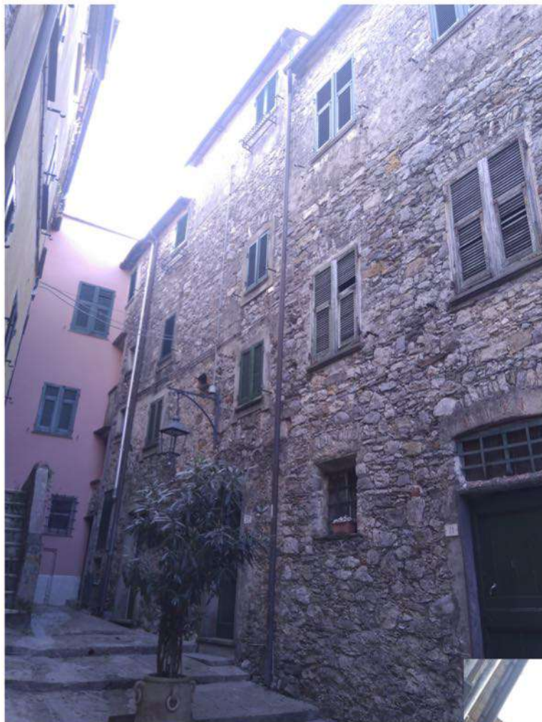
Foto n°3 - Vista dell'immobile da Via delle Mura lato Sud (Piazzetta)
