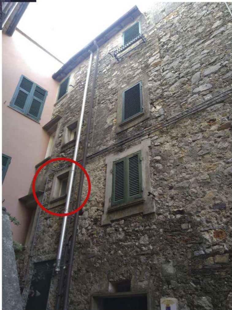
Foto n°4 - Vista di dettaglio apertura su scala comune
