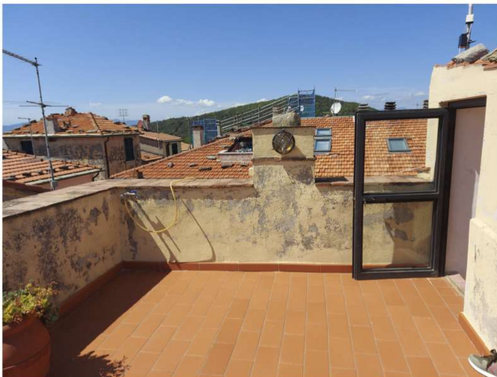
Foto n°1 - Vista del terrazzo/lastrico solare lato Nord
